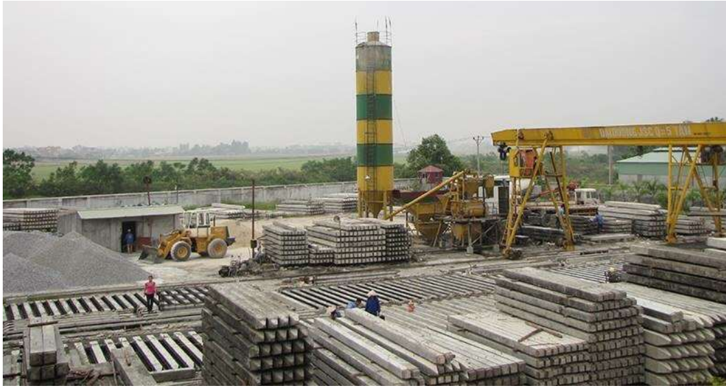
Xưởng đúc cọc Bê tông Công ty TNHH MTV Nguyễn Công Hạnh
