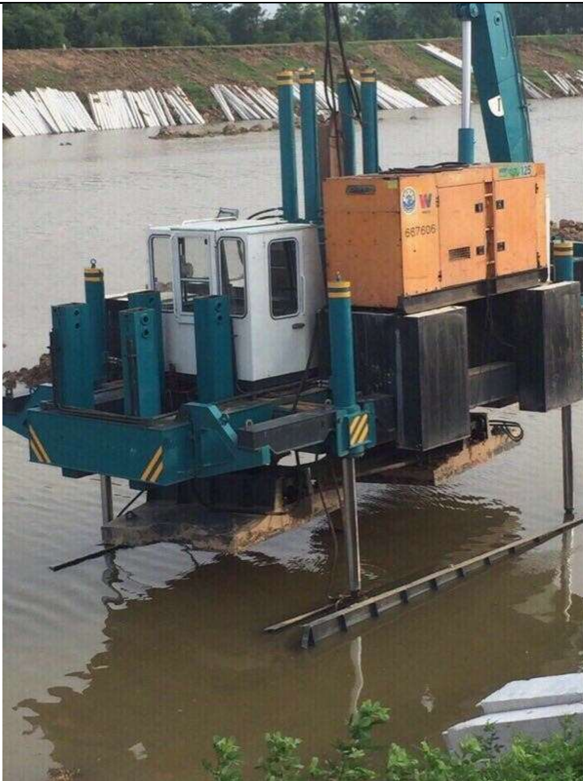
Máy ép cọc Robot thủy lực
