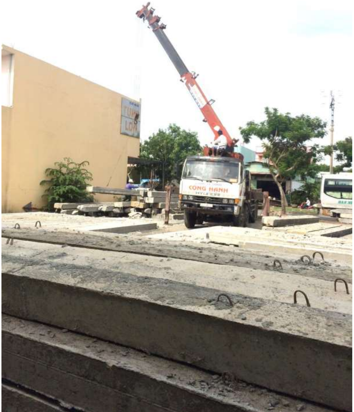
Sản xuất cọc bê tông đại trà công trình Bến xe Đức Long
