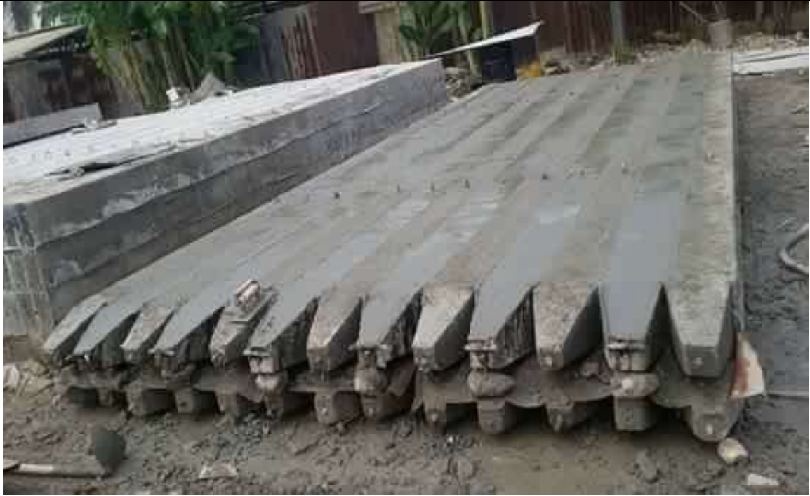
Sản xuất cọc bê tông đại trà Công trình Hòa Bình Green
