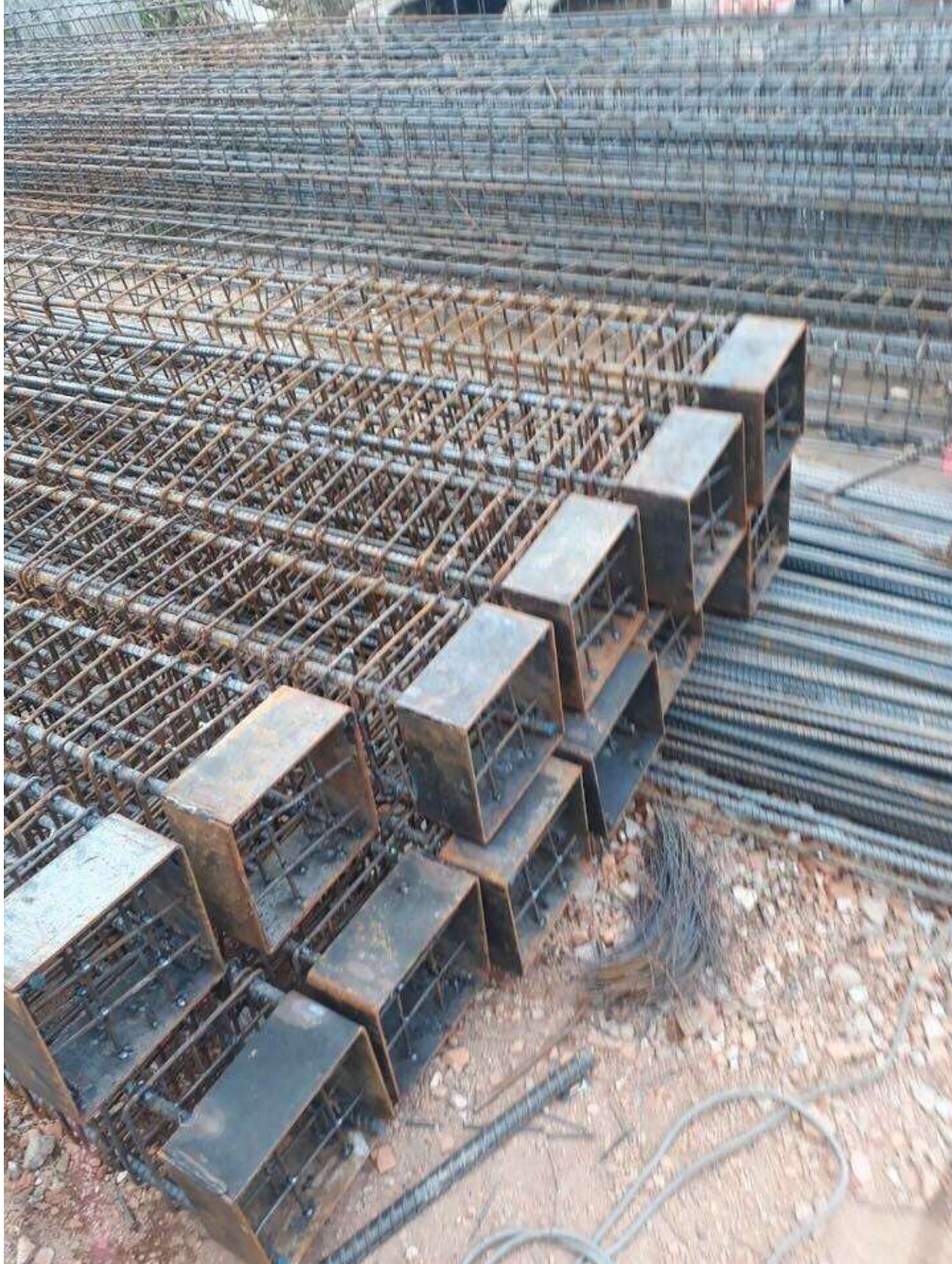
Sản xuất cọc đại trà tại xưởng
