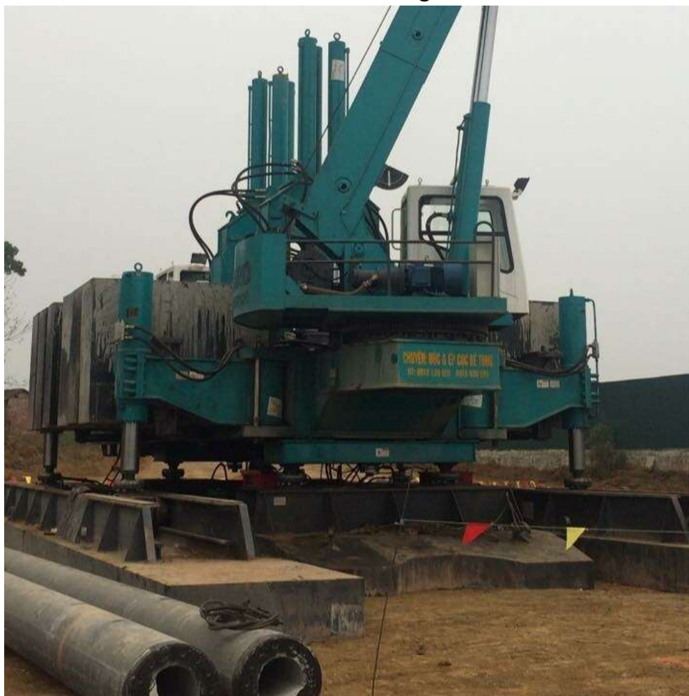
Thi công ép cọc đại trà Công trình khách sạn Holiday
